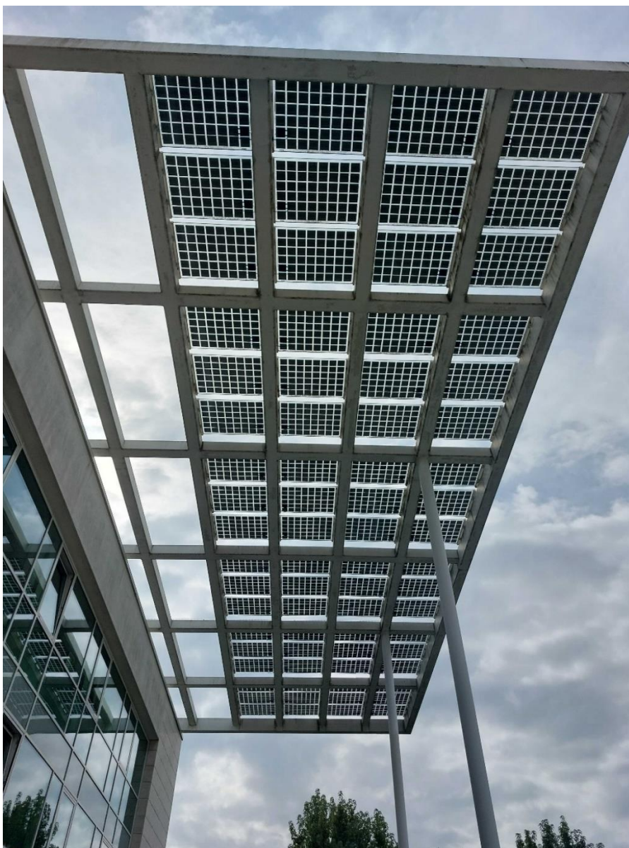
Comando Polizia Locale – impianto FV esistente su pensilina
